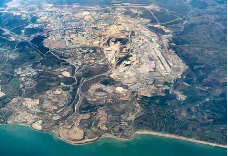
Şekil 5. Kuzey ormanlarını parçalayan ve kuş göç yolu üzerinde bulunan İstanbul Havalimanı
